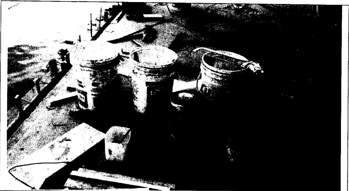
Imagen N° 03: En la presente imagen se puede observar que se hará uso del aditivo sikadur 32 para la adherencia del concreto nuevo con el concreto antiguo, su aplicación será previo al vaciado.
