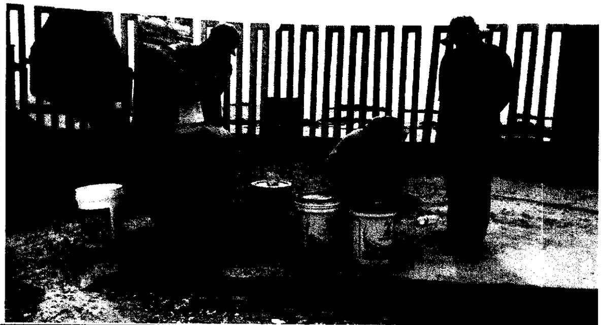
Imagen N° 04: En la presente imagen se puede observar los insumos a utilizar en la composición del concreto para el vaciado de la protección de la defensa del muelle, así como los aditivos plastificante, impermeabilizante, acelerante de fragua y el cemento portland tipo V.
