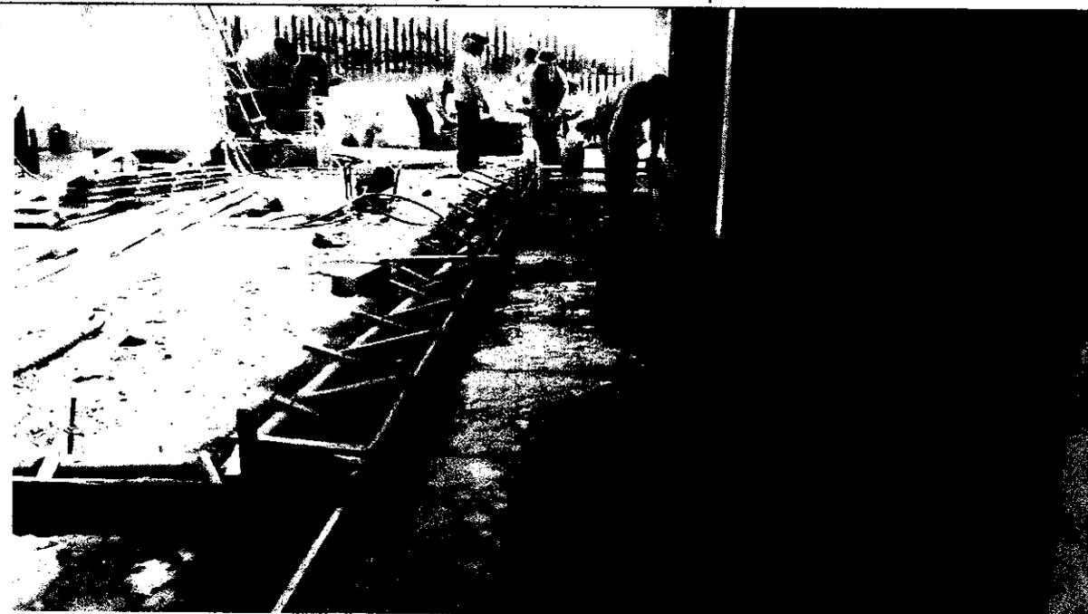
Imagen N° 06: En la presente imagen se puede observar los trabajos encofrado en veredas
