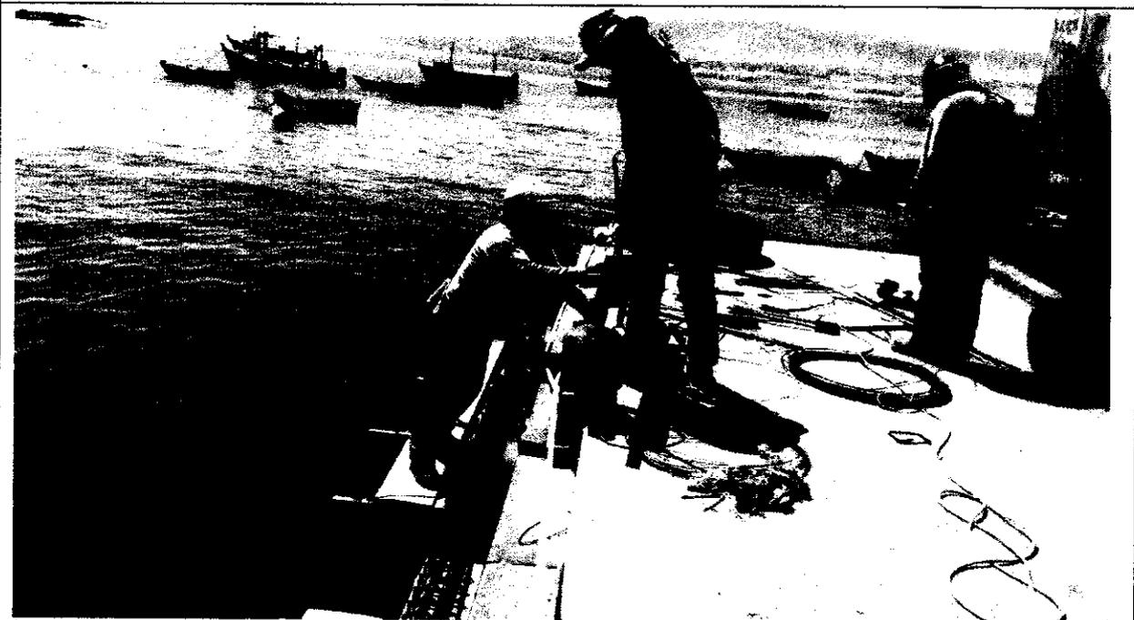
Imagen N° 02: En la presente imagen se puede observar trabajos en protección defensa de muelle así como la colocación de los aceros de refuerzo de diámetro 5/8" y estribos de 3/8"  $f_y=4200$  kg/cm<sup>2</sup>, así mismo se observa el encofrado según las medidas indicadas en los planos.
