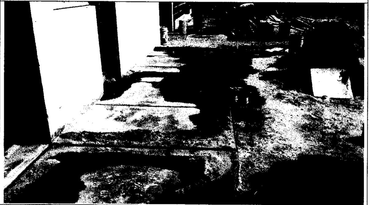
Imagen N° 08: En la presente imagen se puede observar los trabajos curado en veredas.
