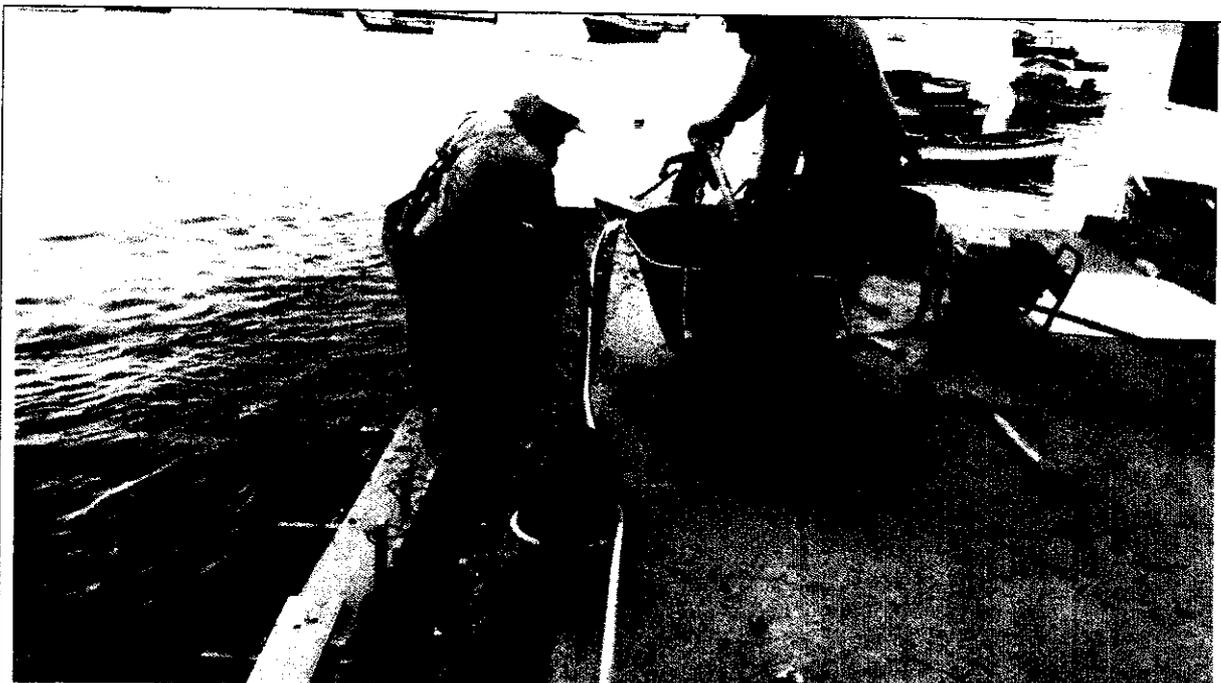
Imagen N° 05: En la presente imagen se puede observar los trabajos de vaciado con concreto  $f_c = 350$  kg/cm<sup>2</sup> en protección de defensa de muelle, así mismo se han obtenido muestras de concreto en probetas cilíndricas de pvc para su ensayo de resistencia a la compresión.
